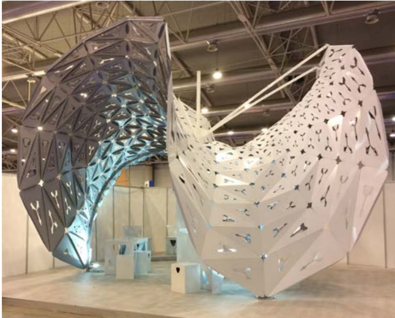
Enneper Pavilion – Padiglione progettato e realizzato attraverso l'utilizzo di macchinari CNC 7
